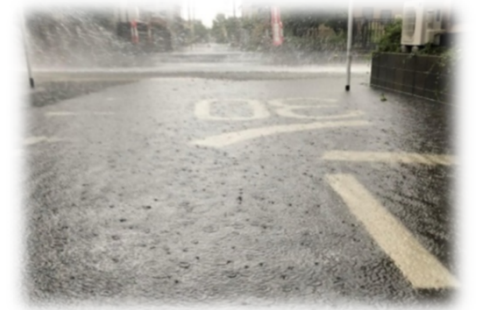
(冠水した道路)
