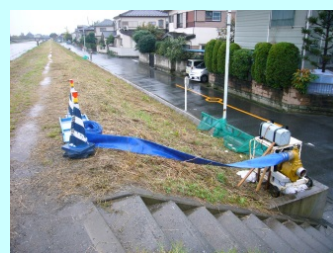
③、④非常用(仮設)ポンプの増強と配置の再確認が必要
