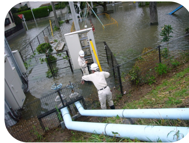
(台風26号時、排水ポンプを点検する作業員)
